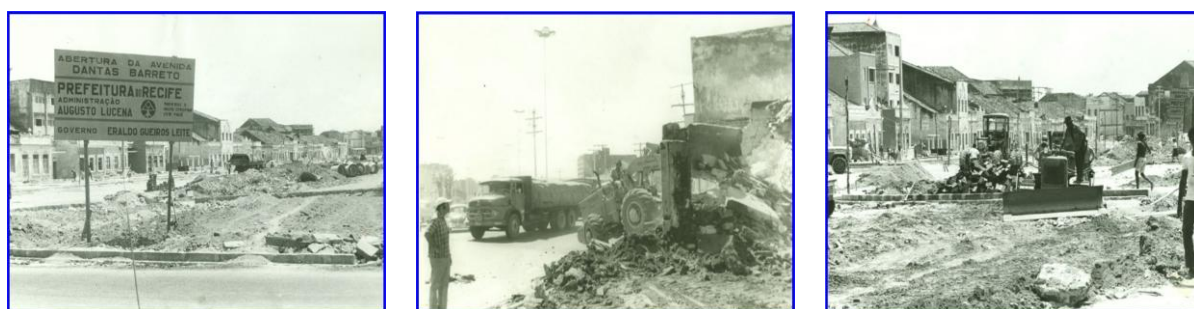
Fig. 2, 3 e 4. Etapas de construção da Av. Dantas Barreto.
